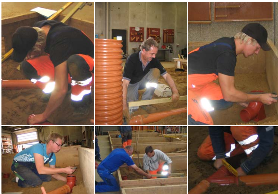
Anlægsstruktøren arbejder blandt andet med nedgravning af forsyningsledninger og praktisk kloakering.
